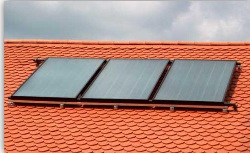
napelem elhelyezése hagyományos hódfarkú cserépfedésen
