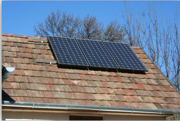
napelemek elhelyezése régebbi típusú épületen
