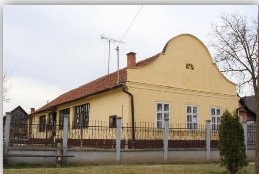
Nagy utca 55. Barokk oromzatú népi lakóház
