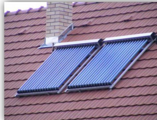
napkollektorok egymás melletti elrendezése
