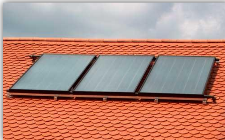
napelem elhelyezése hagyományos hódfarkú cserépfedésen
