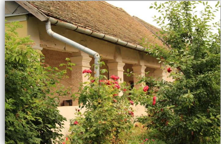
Sáránd, Nagy utca 62. – féltornácos épület
