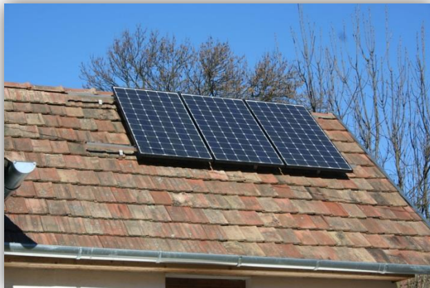
napelemek elhelyezése régebbi típusú épületen
